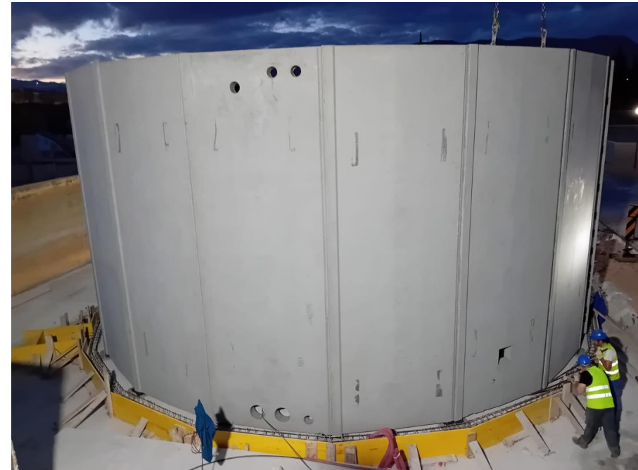
Construcción de digestor en EDAR Crevillente
